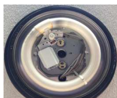
共用部 廊下 FCL30W 蛍光灯から 環型13W LED灯への換装
