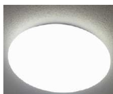
エントランス ダウンライト 40W白熱電球から電球型7W LED灯への換装
