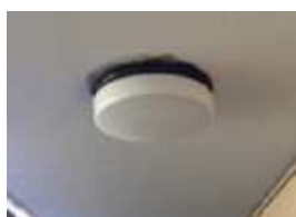
共用部 廊下 FCL30W 蛍光灯から 環型13W LED灯への換装
