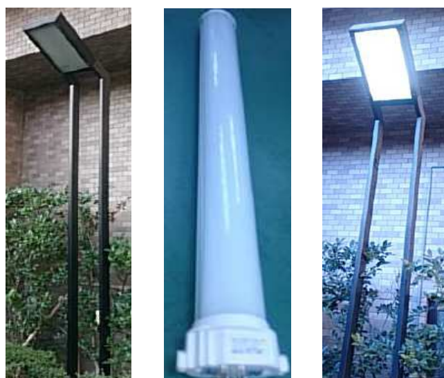
植え込み街灯(背高タイプ) ツイン型蛍光灯からツイン型LED灯への換装
