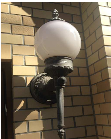
外壁灯 40W白熱電球から電球型7W LED灯への換装
