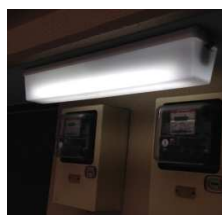
共用部 廊下 FLR20S 20W 蛍光灯から 直管型10W LED灯への換装
