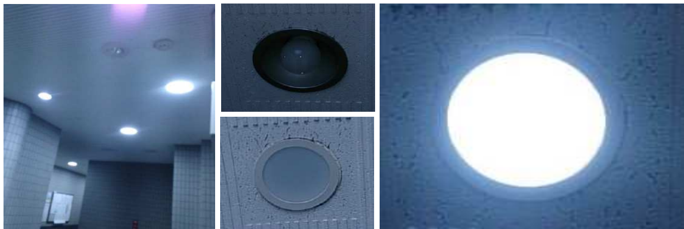
エントランス、メールコーナー、エレベーター前 ボール型蛍光灯から一体型ダウンライトへの換装
