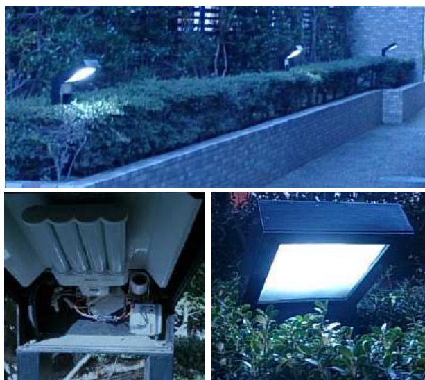
植え込み街灯(背低タイプ) コンパクト型蛍光灯からコンパクト型LED灯への換装
