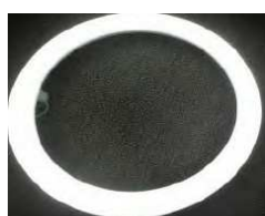
共用部 廊下 FCL30W 蛍光灯から 環型13W LED灯への換装
