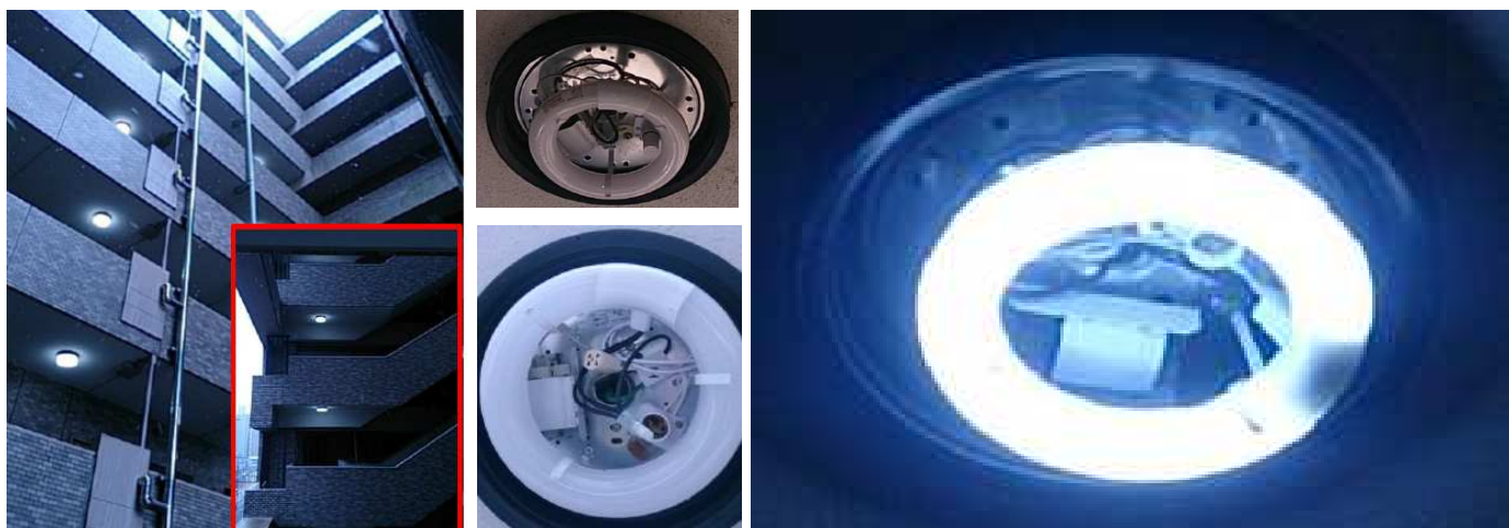
2階～13階共用通路非常階段 サークラインから環型LED灯への換装
