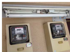
共用部 廊下 FLR20S 20W 蛍光灯から 直管型10W LED灯への換装
