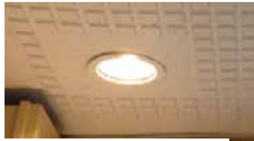
エントランス ダウンライト 40W白熱電球から電球型7W LED灯への換装
