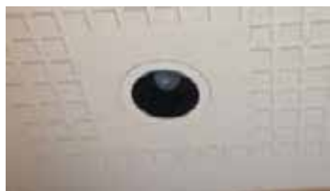
エントランス ダウンライト 40W白熱電球から電球型7W LED灯への換装
